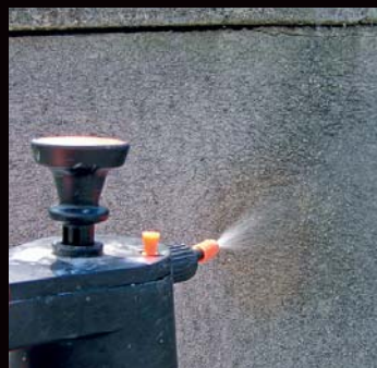
Aplikace materiálu SOLUZIONE COMBAT nástřikem
